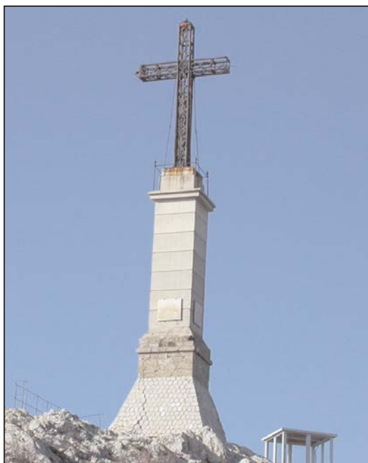
La croix avant travaux
