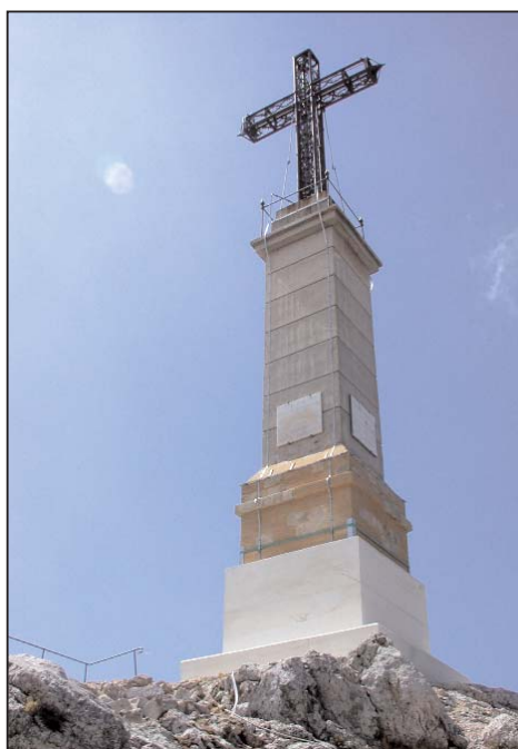
La croix après travaux
