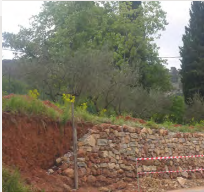
Muret en pierres sèches en cours de restauration le long de la Route Cézanne (source : © GSSV)
