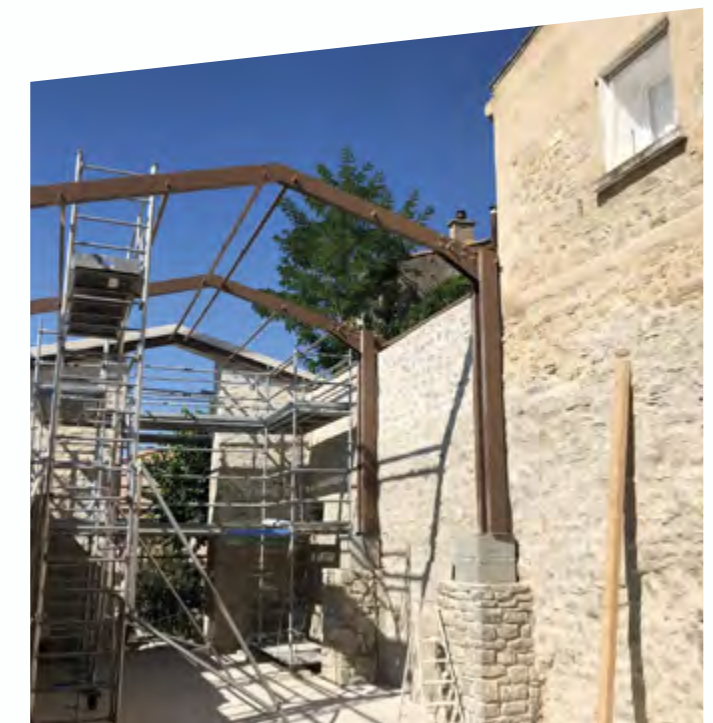
Restauration et reconstruction de la structure métallique pour la chapelle Sainte Marie à Puylobier (source : www.cerni.fr)
