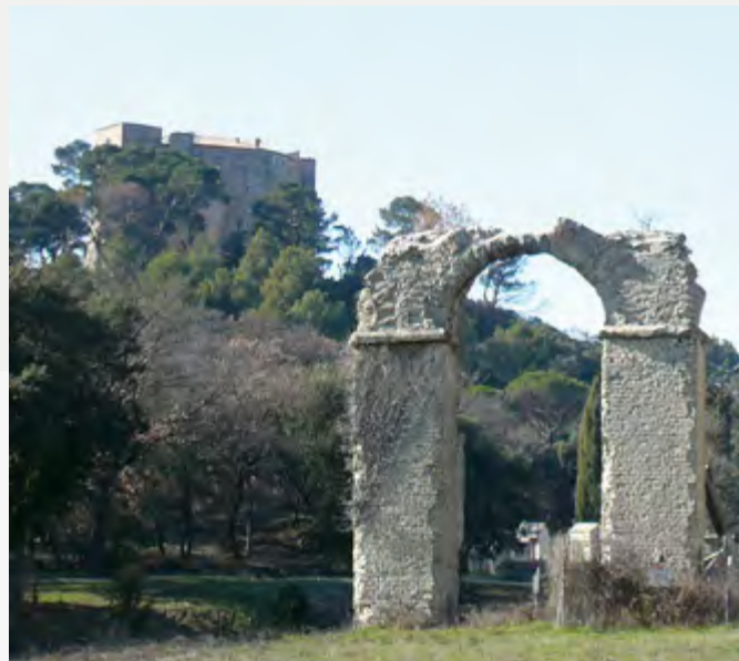
Aqueduc de Meyrargues avec le château en arrière-plan (source : © GSSV)
