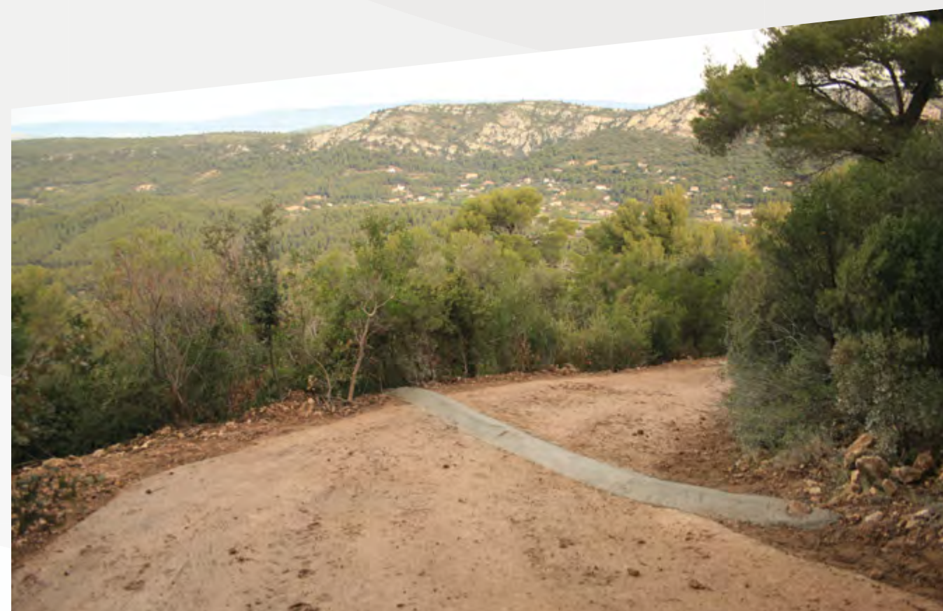
Réhabilitation de la piste des Venturiers sur Sainte-Victoire (source : photo de chantier / ONF)
