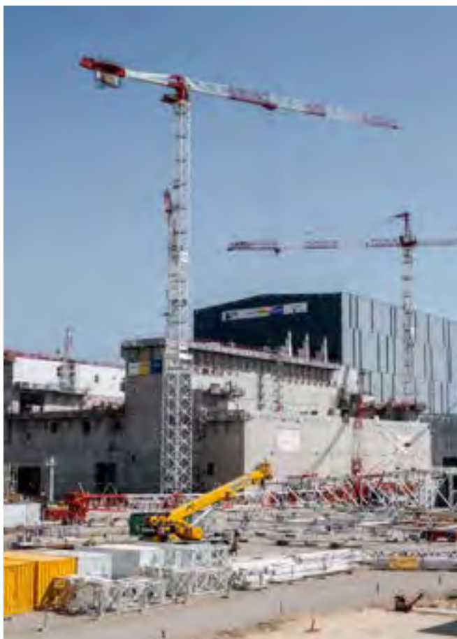
Chantier du centre CEA de Cadarache © MAMP
