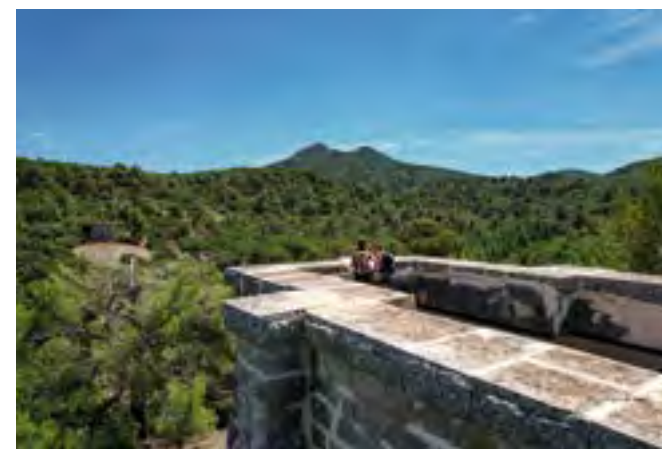
Siphon aval de Tremпасse - Ancien Canal du Verdon aménagé en itinéraire de randonnée © MAMP
