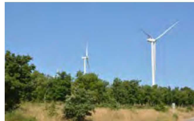
Parc éolien d'Artigues et d'Ollières depuis la RD3 © Caudex
