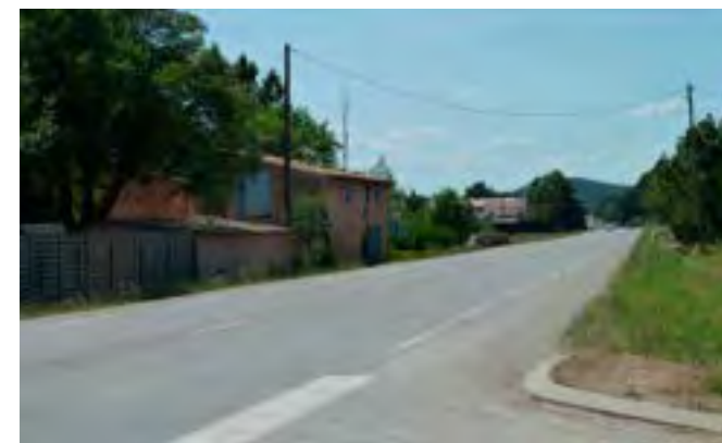
Les abords de la RD7 accueillant bâti et lignes électriques peu intégrés © MAMP
