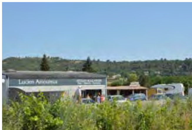
Entrée de ville de Rians le long de la RD3 © Caudex
